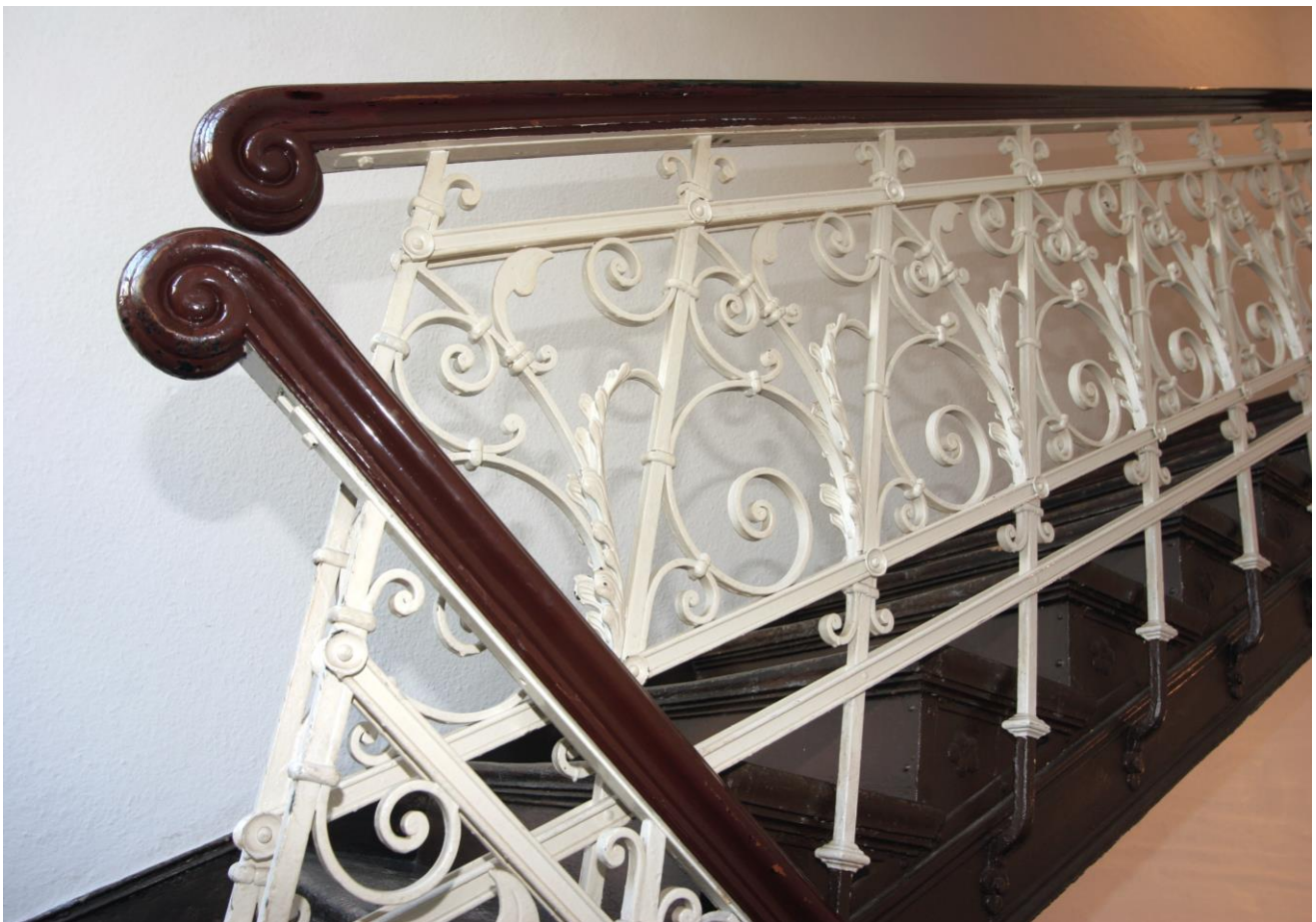
Treppengeländer im Museum Villa Stahmer, Foto: Stadt Georgsmarienhütte, Gisbert Gramberg
