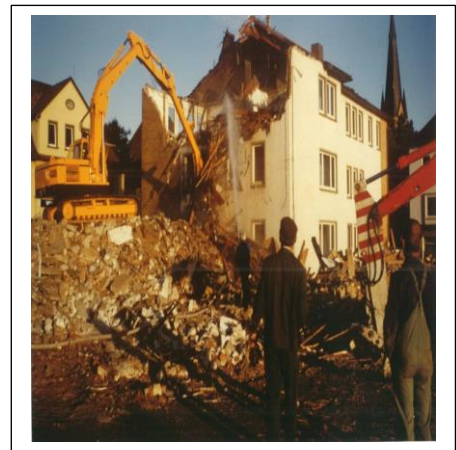
Abbruch des alten Oeseder Rathauses 1990. Foto: Stadt Georgsmarienhütte/Sammlung Werner Beermann.
